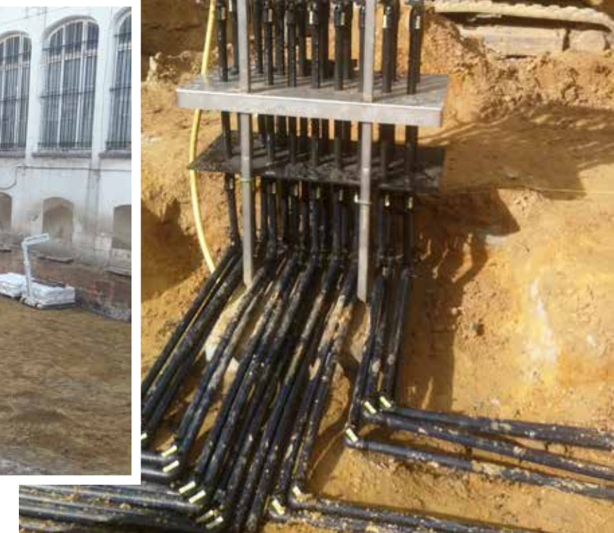
La phase suivante a consisté à raccorder en parallèle les forages aux collecteurs.
