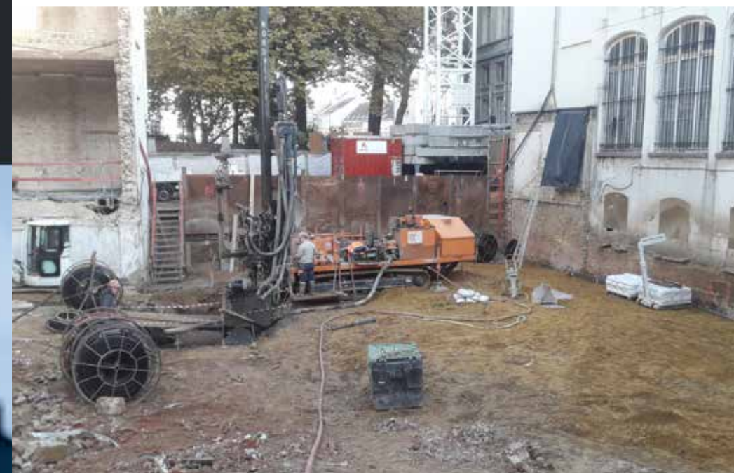
Depuis le fond de la fosse de construction, Verbeke a réalisé 9 forages rotary à l'eau à 95 m de profondeur dans des couches sédimentaires de sable et d'argile.
