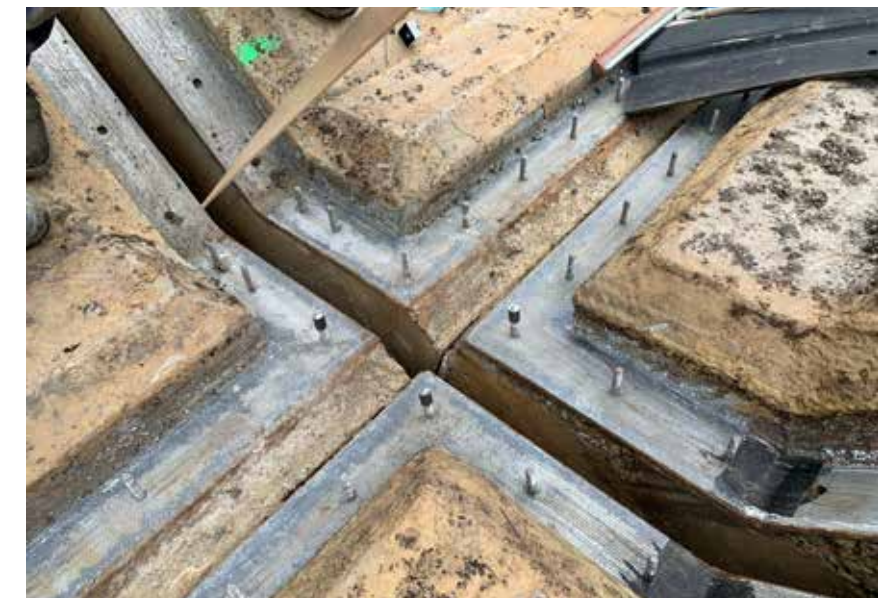
20 000 écrous en inox ont dû être démontés puis remontés.
