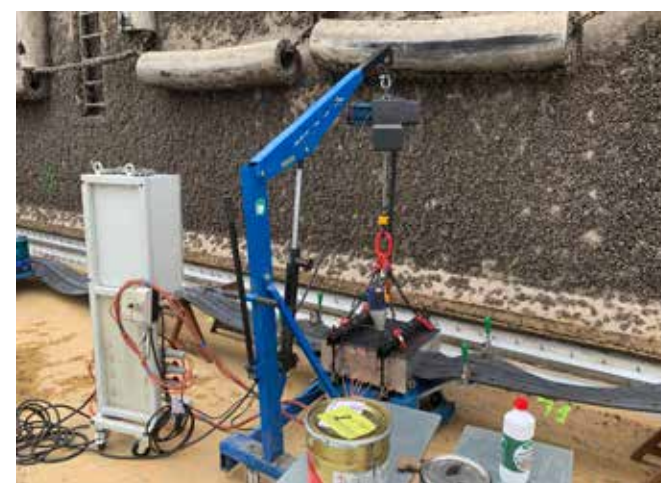
Une presse mobile de petite taille a été mise au point pour vulcaniser sur chantier les joints.
