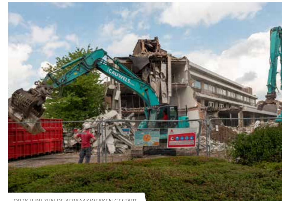
OP 18 JUNI ZIJN DE AFBRAAKWERKEN GESTART
