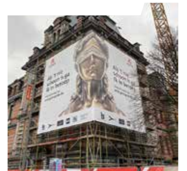
artes_group Geen nood, Vrouwe Justitia. Onze #constructivepeople stellen nooit teleur! 🙌 #restauratie #renovatie #oudgerechtshof #artesgroup #construction #aannemer #hardwork #renovation #restauratie #ladyjustice
